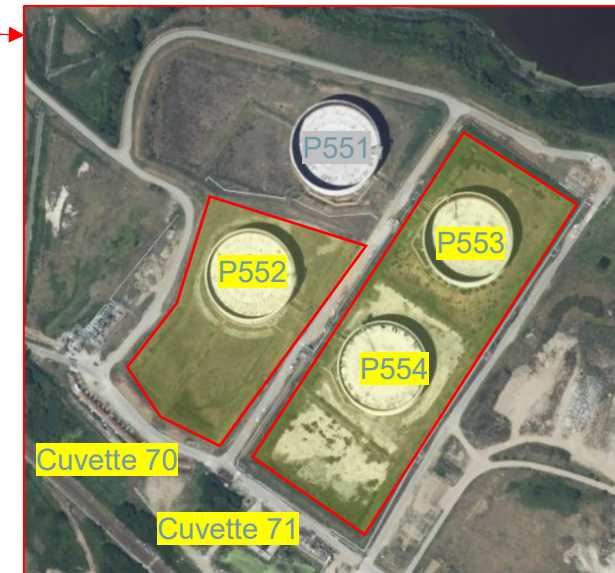
2 cuvettes en traitement de matériaux de surface
