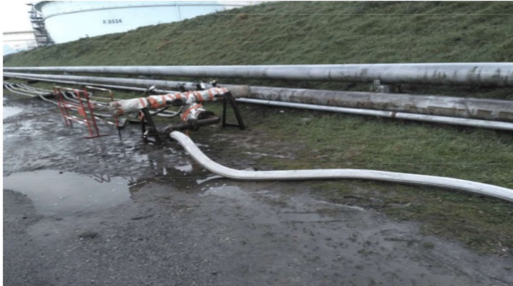
Tuyaux mis en œuvre pour la connexion de la maintrap au bac P552
