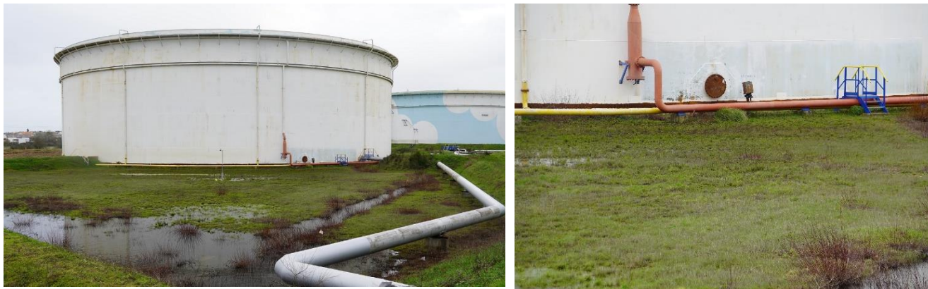
Figures n°10 et n°11 : état de surface de la cuvette de rétention
