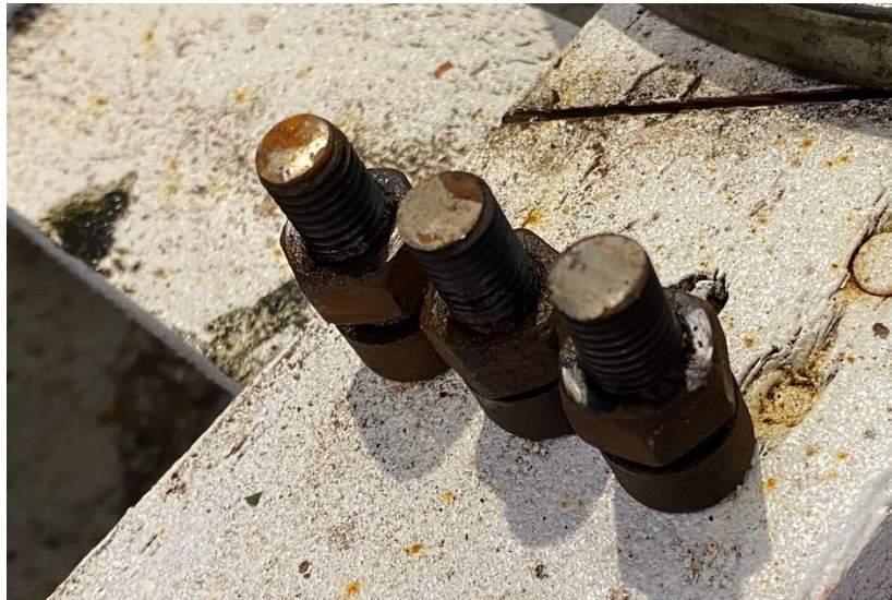
Figure n°8 : vis de fixation de la coupole
